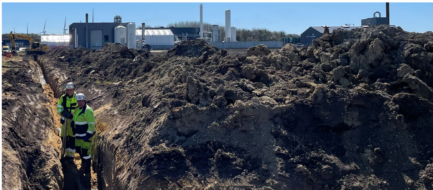
Anlægsarbejde i forbindelse med etableringen af Evidas brinttestrørstrækning.
